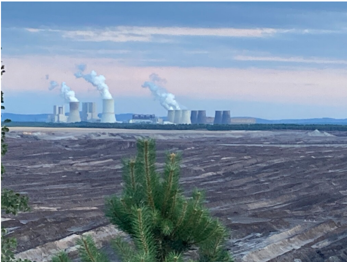
Teil der Objektgruppe Tagebau Nochten (31000343), Innenkippe mit Geländeprofil nach Abraumverstoß durch den Förderbrückenverband von der nördlichen Tagebaukante aus gesehen. Im Hintergrund bereits der geplante Bereich der Absetzerkippe Fotograf/Urheber: Tom Pfefferkorn
