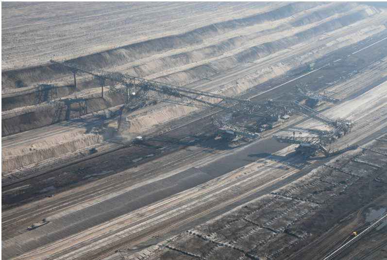
Teil der Objektgruppe Tagebau Nochten (31000343), Abraumförderbrücke AFB 33 F 60 Fotograf/Urheber: Ronald Heynowski
