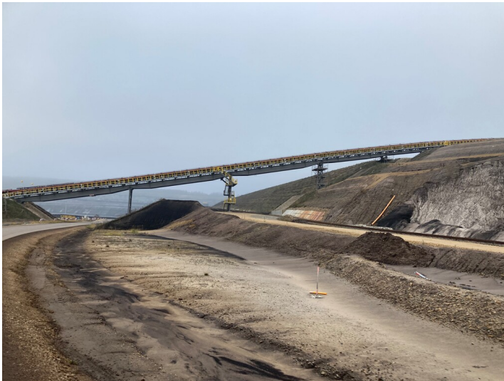
Teil der Objektgruppe Tagebau Nochten (31000343), Abraumbandanlage aus mehreren Einzelbändern, Bandantriebsstationen und einem Bandschleifenwagen Fotograf/Urheber: Tom Pfefferkorn
