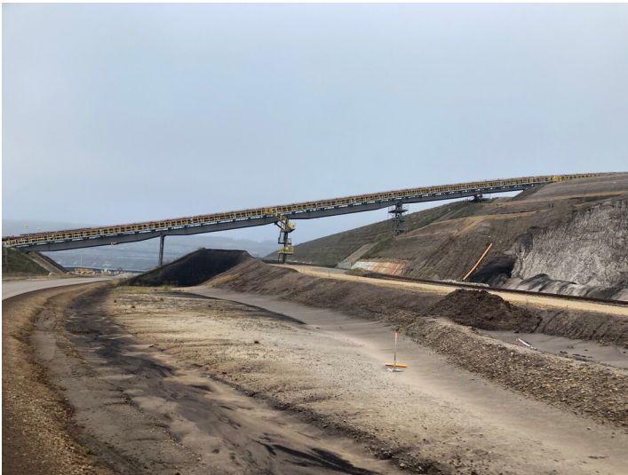
Teil der Objektgruppe Tagebau Nochten (31000343), Abraumbandanlage aus mehreren Einzelbändern, Bandantriebsstationen und einem Bandschleifenwagen Fotograf/Urheber: Tom Pfefferkorn
