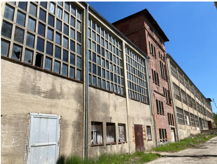
Margarethenhütte, Nachfolgebetrieb, Werkhallen der 1960er bis 1980er Jahre Fotograf/Urheber: Nora Wiedemann
