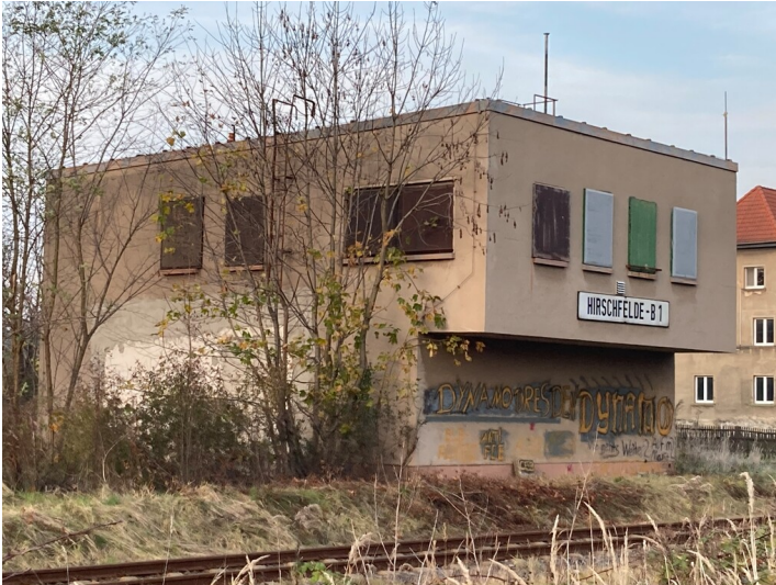
Kraftwerk Hirschfelde, Werkbahn, Stellwerk des ehem. Bahnhofs Fotograf/Urheber: Tom Pfefferkorn
