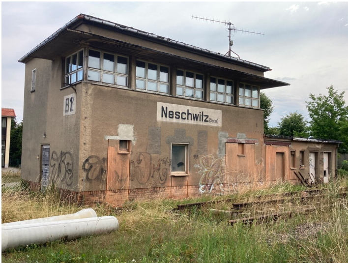
Ehemaliger Bahnhof Neschwitz, Stellwerk Fotograf/Urheber: Tom Pfefferkorn
