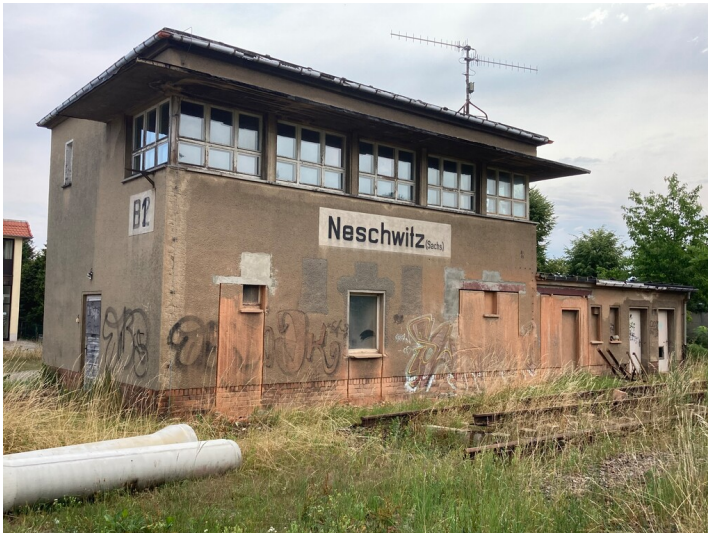
Ehemaliger Bahnhof Neschwitz, Stellwerk Fotograf/Urheber: Tom Pfefferkorn
