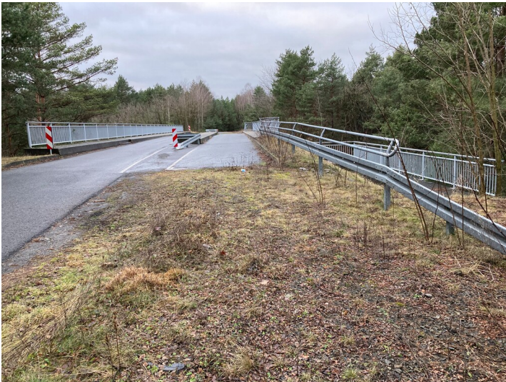
LGB Knappenrode-Lohsa-Boxberg, ehemalige Kohlebahnbrücke über die Bahnstrecke 6579 Königswartha - Weißkollm Fotograf/Urheber: Tom Pfefferkorn
