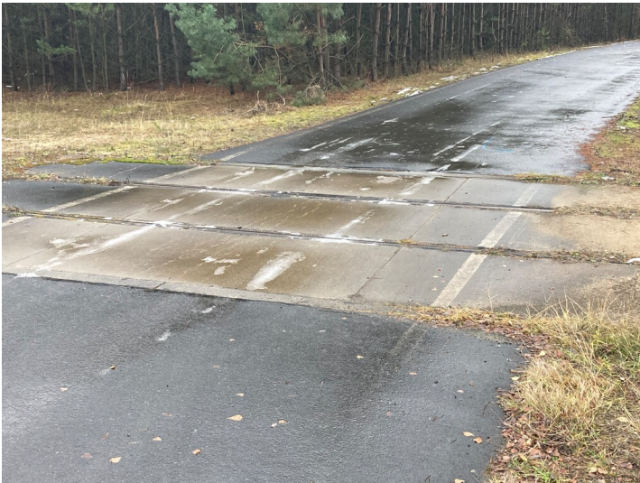
Anschlussbahn Uhyst - Boxberg (zweite, westliche Streckenführung) - Straßenquerung nördlich des Bärwalder Sees Fotograf/Urheber: Tom Pfefferkorn
