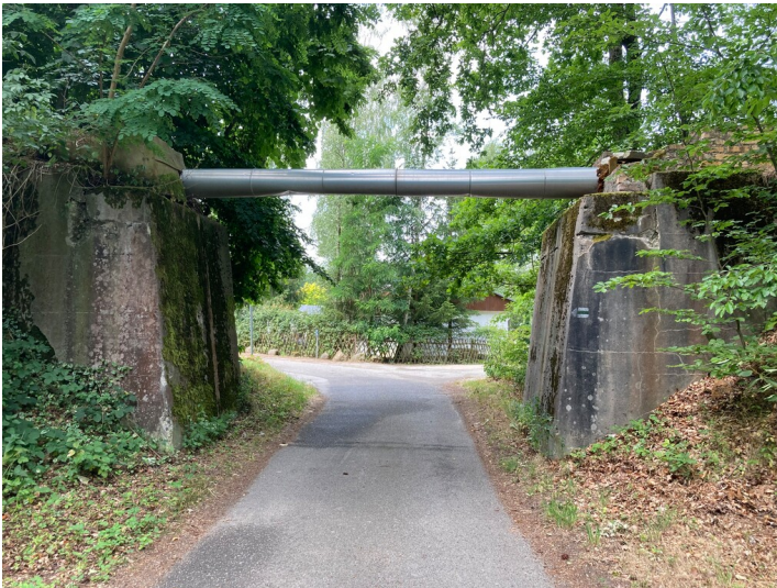
Frühere Werkbahn der Adolfschütte Quoos - Crosta, Widerlager der früheren Überführung bei Crosta Fotograf/Urheber: Tom Pfefferkorn
