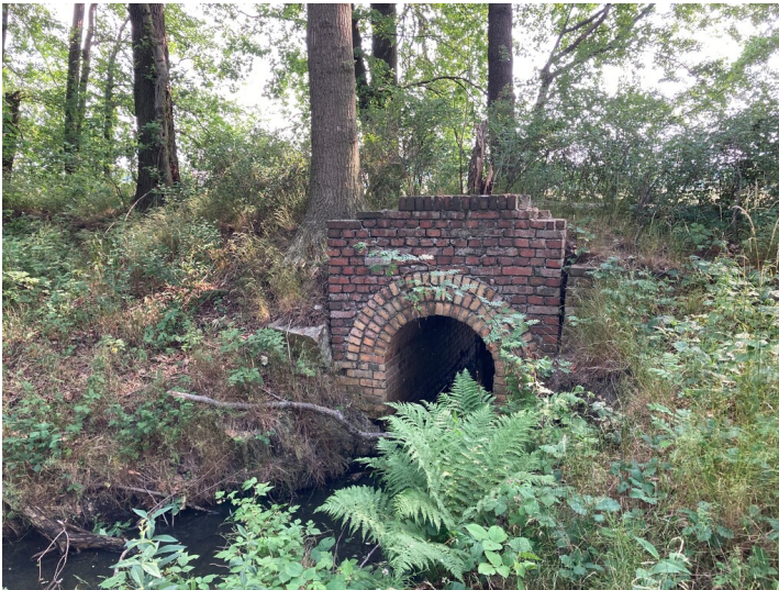
Anschlussbahn Brikettfabrik Skaska, Durchlass im Bereich der Weißiger Teiche Fotograf/Urheber: Matin Neubacher
