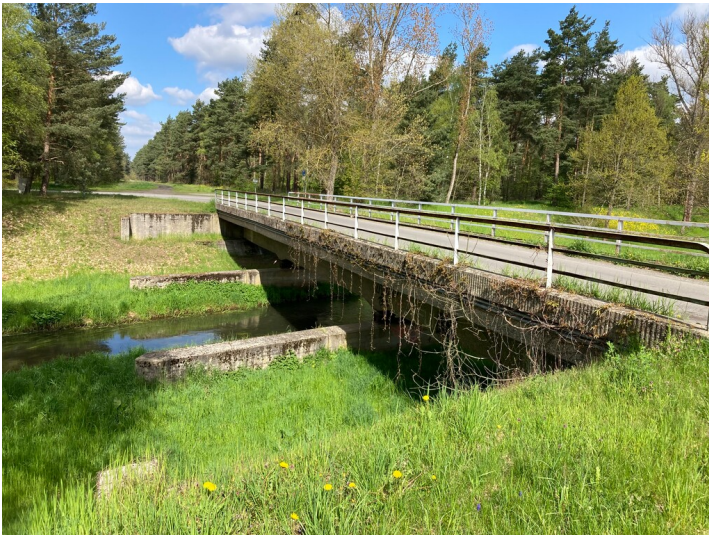
Strecke 6207, Verlegung bei Lohsa, als Straßenbrücke nachgenutzte Eisenbahnbrücke über die verlegte Kleine Spree Fotograf/Urheber: Tom Pfefferkorn
