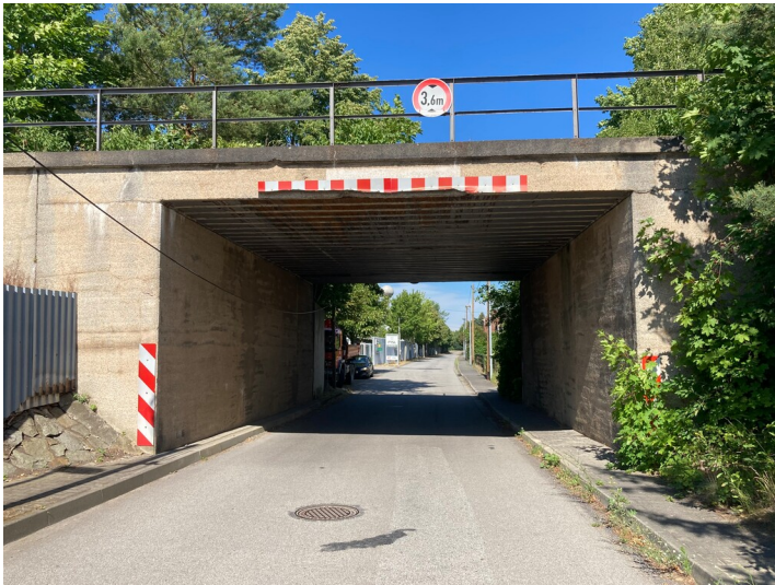
Strecke 6606 Königsbrück - Straßgräbchen-Bernsdorf, Bahnstabsbrücke in Schwepnitz Fotograf/Urheber: Tom Pfefferkorn
