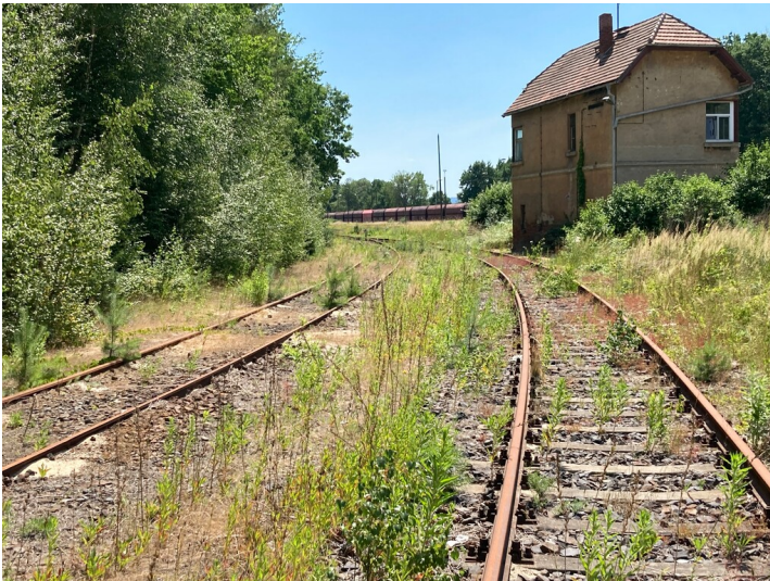
Strecke 6595 Straßgräbchen - Hoyerswerda (Zeiðholzbahn), Streckenrest im Bahnhof Straßgräbchen-Bernsdorf Fotograf/Urheber: Tom Pfefferkorn
