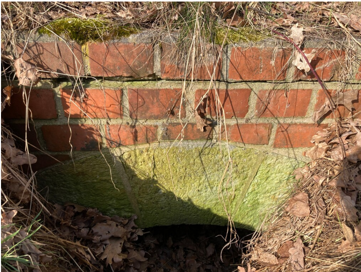
Strecke 6593 Neupetershain - Hoyerswerda (sächsischer Teil), Durchlass im Bahndamm bei Bergen Fotograf/Urheber: Tom Pfefferkorn
