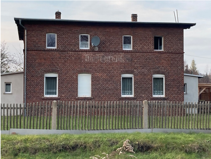
Strecke 6589 Zittau - Hagenwerder, Bahngebäude am Bahnhof Hirschfelde Fotograf/Urheber: Tom Pfefferkorn
