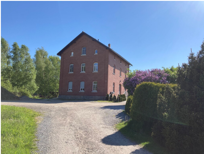
Strecke 6581 Löbau - Radibor, ehemaliger Bahnhof Baruth Fotograf/Urheber: Nora Wiedemann
