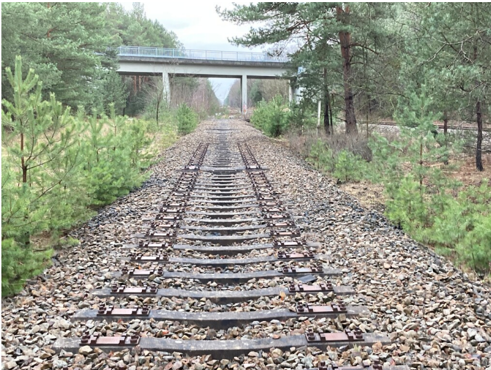
Strecke 6579neu Königswartha - Weißkollm, demontierte Strecke bei Lohsa Fotograf/Urheber: Tom Pfefferkorn
