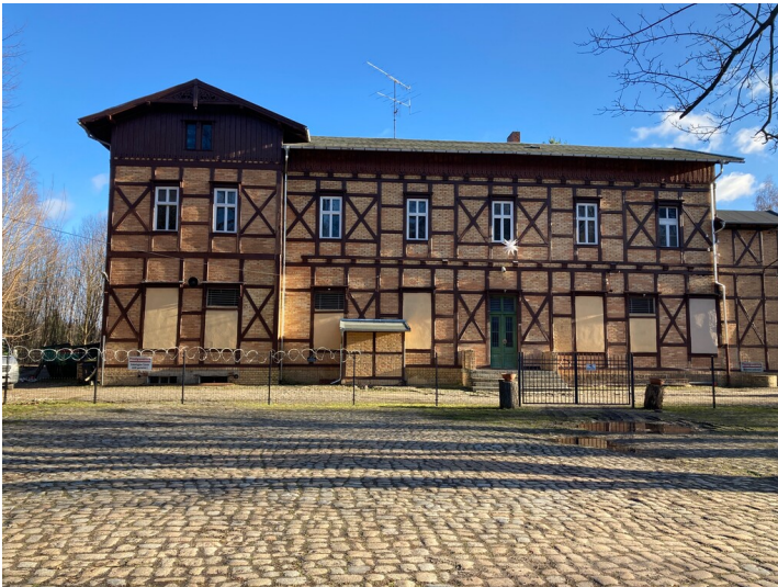
Strecke 6576 Weißwasser - Muskau - (Lubsko/Sommerfeld), Bahnhofsgebäude Bad Muskau, heute in Privatbesitz Fotograf/Urheber: Matin Neubacher
