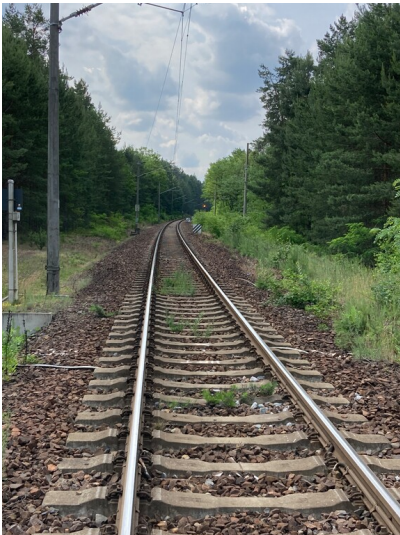
Strecke 6222 Abzweig Spreewitz Süd - Abzweig Graustein, freie Strecke bei Neustadt Fotograf/Urheber: Tom Pfefferkorn
