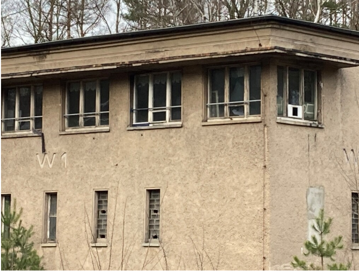
Strecke 6207 Roßlau - Horka Gr - Wegliniec (sächsischer Teil), ehemaliges Stellwerk am Bahnhof Knappenrode Fotograf/Urheber: Tom Pfefferkorn
