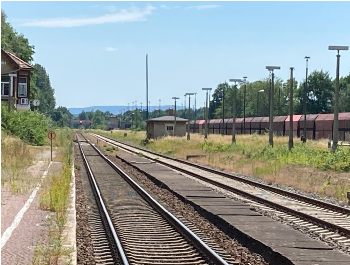
Strecke 6194/6198 Kamenz - Senftenberg (sächsischer Teil), Bahnhof Straßgräbchen-Bernsdorf Fotograf/Urheber: Tom Pfefferkorn
