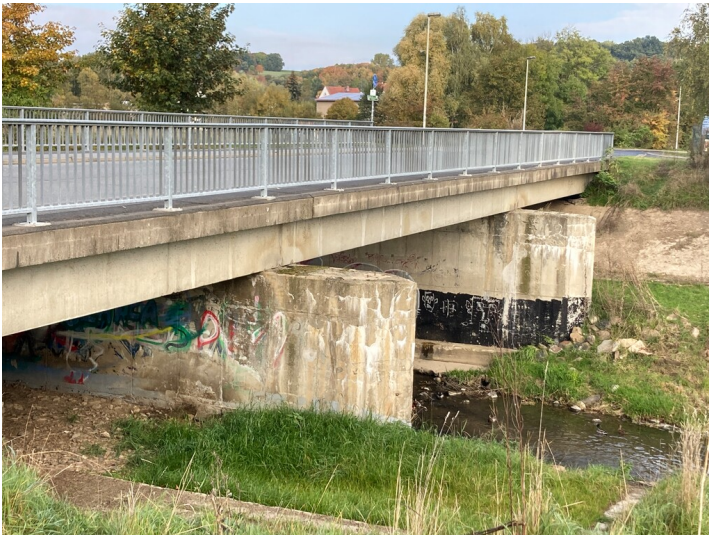
60 Mp-Brücke über die Mandau Fotograf/Urheber: Kathrin Krüner
