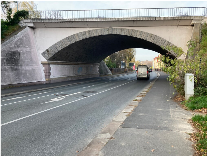
Bahnstrecke Zittau - Hagenwerder, Eisenbahnbrücke über die Schillerstraße (Nordbrücke) Fotograf/Urheber: Tom Pfefferkorn
