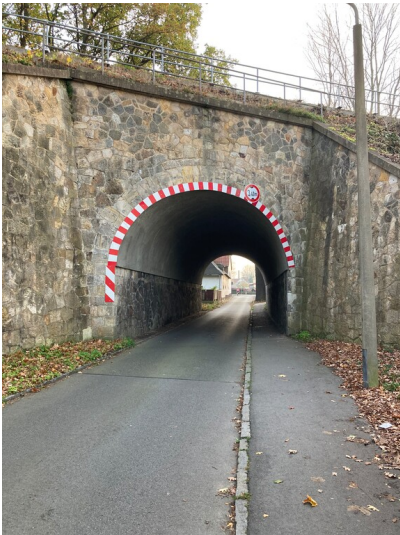
Bahnstrecke Zittau - Hagenwerder, Eisenbahnbrücke über die Roseggerstraße, Ansicht von Norden Fotograf/Urheber: Tom Pfefferkorn
