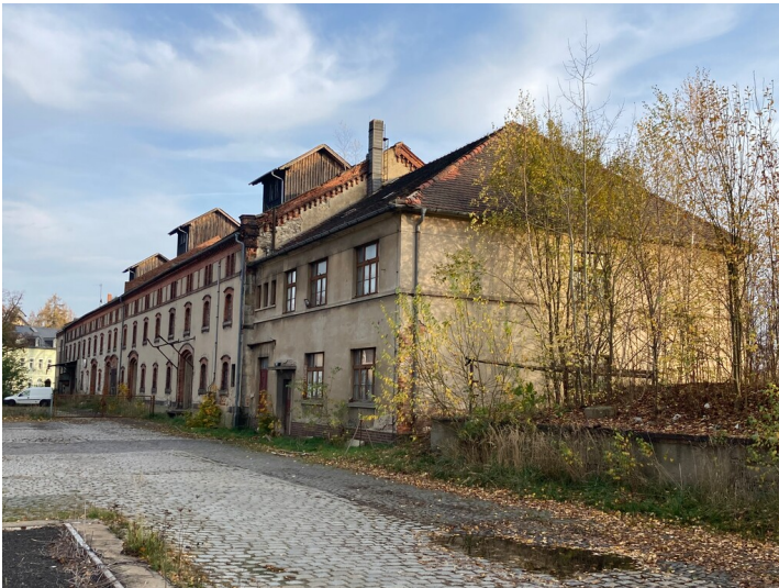
Bahnhof Zittau, östlicher Güterschuppen, Ansicht aus Richtung Westen Fotograf/Urheber: Tom Pfefferkorn
