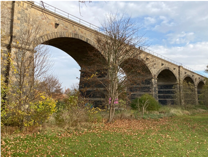
Bahnstrecke Zittau - Liberec, Neißetalviadukt, von Südwesten Fotograf/Urheber: Tom Pfefferkorn
