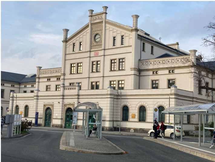
Bahnhof Zittau, Empfangsgebäude, Ansicht von Südosten Fotograf/Urheber: Tom Pfefferkorn
