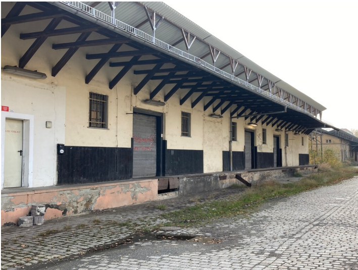
Bahnhof Zittau, mittlerer Güterschuppen, Blickrichtung Westen Fotograf/Urheber: Tom Pfefferkorn
