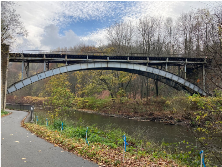
Zwei Eisenbahnbrücken im Neißetal, südliche Brücke, Ansicht von Süden Fotograf/Urheber: Tom Pfefferkorn
