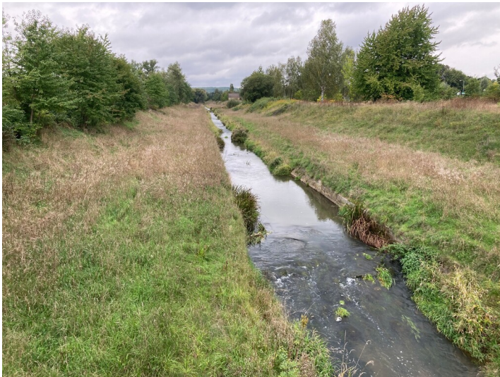
Verlegung der Pließnitz für den Tagebau Berzdorf, hier zwischen ehemaligem Kraftwerksgelände und Tauchritz Fotograf/Urheber: Tom Pfefferkorn
