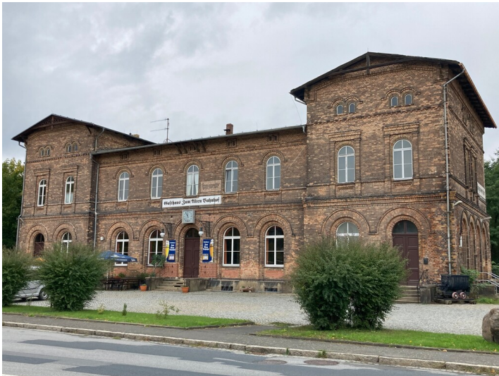
Bahnhof Hagenwerder, Hauptansicht zur Straße Fotograf/Urheber: Tom Pfefferkorn
