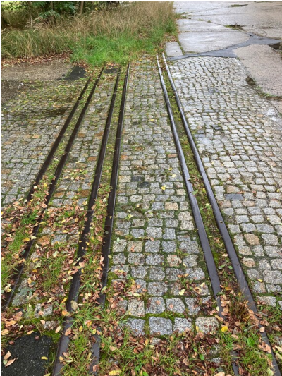
Werkbahn des Tagebaues Berzdorf und des Kraftwerkes Hagenwerder, Reste des Dreischienengleises Fotograf/Urheber: Tom Pfefferkorn
