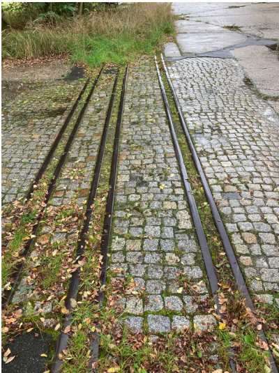
Werkbahn des Tagebaues Berzdorf und des Kraftwerkes Hagenwerder, Reste des Dreischienengleises Fotograf/Urheber: Tom Pfefferkorn
