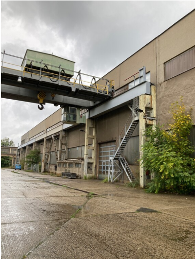
Tagesanlagen Berzdorf, Werkstatthalle der 1980er Jahre, von Südosten Fotograf/Urheber: Kathrin Krüner
