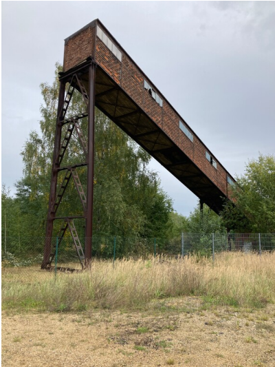
Schrägbandbrücke der Siebanlage, von Südwesten gesehen Fotograf/Urheber: Kathrin Krüner
