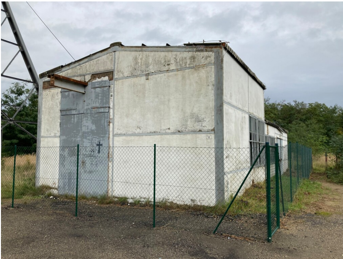
Skipschachtanlage Schacht 3, Maschinenhaus Fotograf/Urheber: Tom Pfefferkorn
