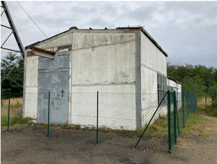
Skipschachtanlage Schacht 3, Maschinenhaus Fotograf/Urheber: Tom Pfefferkorn
