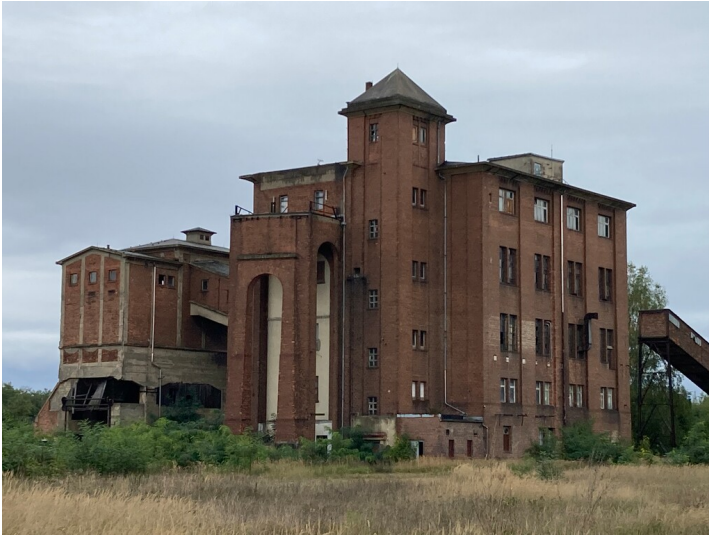
Tagesanlagen Berzdorf, Hochbunker/Siebanlage der 1. Nutzungsphase in den 1920er Jahren, Ansicht von Süden Fotograf/Urheber: Tom Pfefferkorn
