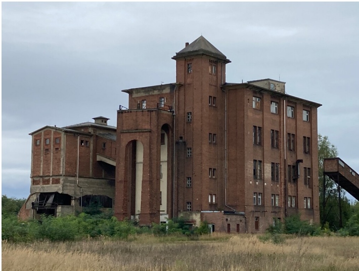
Tagesanlagen Berzdorf, Hochbunker/Siebanlage der 1. Nutzungsphase in den 1920er Jahren, Ansicht von Süden Fotograf/Urheber: Tom Pfefferkorn
