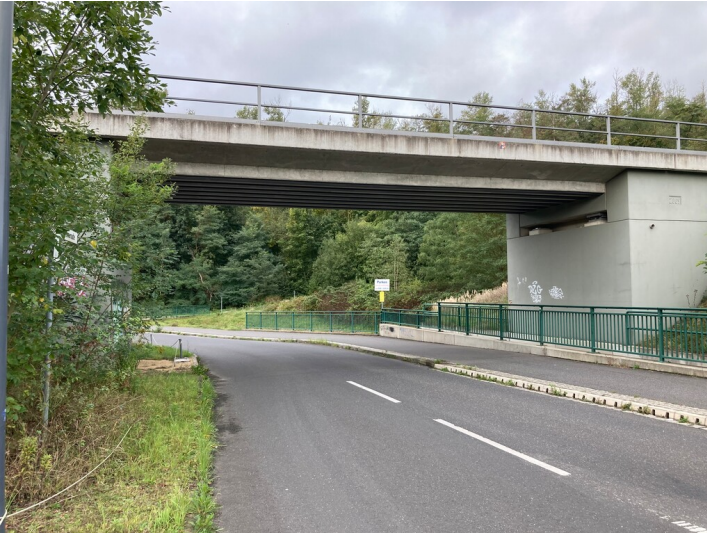
Strecke 6590 Görlitz-Hagenwerder, Verlegung bei Deutsch Ossig, Brücke über die Strandpromenade Fotograf/Urheber: Tom Pfefferkorn
