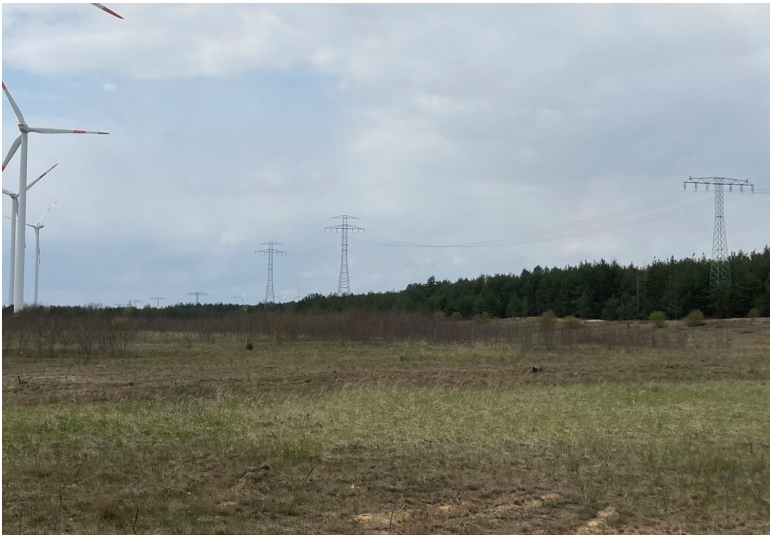
Stark erhöhte Überführung einer Hochspannungsleitung über eine Großgerätetrassentrasse, hier nördlich des Scheibesees Fotograf/Urheber: Nora Wiedemann
