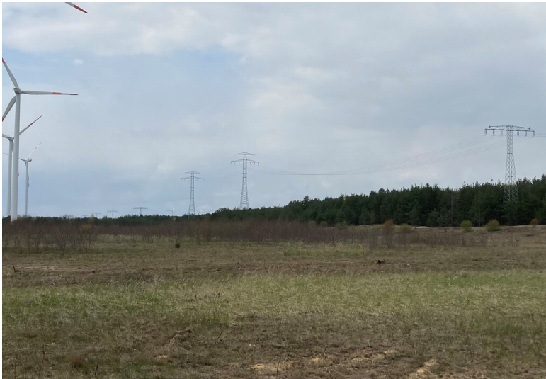
Stark erhöhte Überführung einer Hochspannungsleitung über eine Großgerätetrassentrasse, hier nördlich des Scheibesees Fotograf/Urheber: Nora Wiedemann
