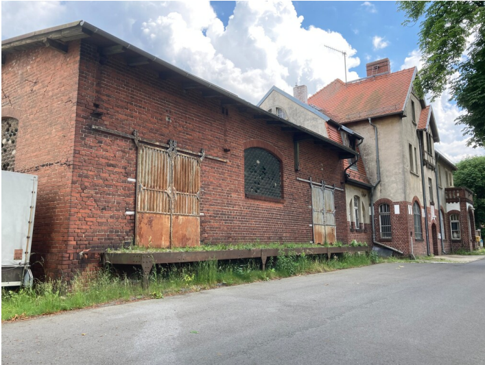
Bahnhof Wiednitz, Ortsseite (West) von Norden Fotograf/Urheber: Nora Wiedemann
