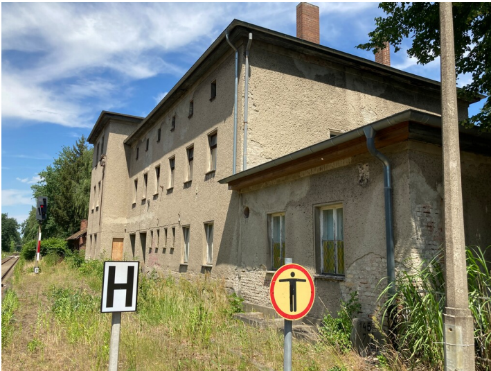
Bahnhofsgebäude von der Gleisseite aus (Süden) Fotograf/Urheber: Tom Pfefferkorn
