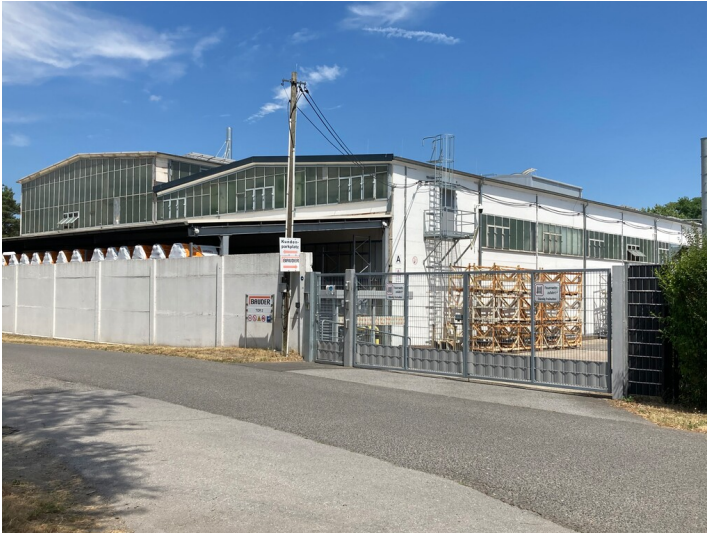
ehemalige Glashütte, nach 1950 Thermoplastwerk, Ansicht Fabrikweg (von Westen) Fotograf/Urheber: Tom Pfefferkorn
