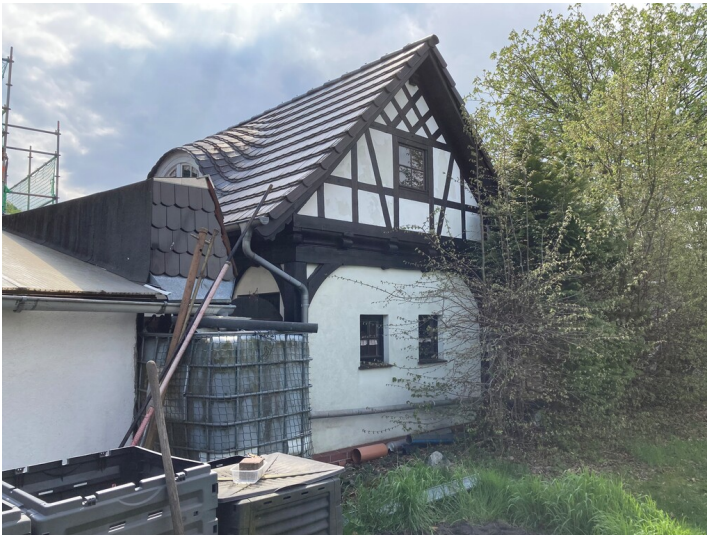
Ehemaliges Toilettenhäuschen des Bahnhofes Knappenrode, Ansicht von Nordosten Fotograf/Urheber: Nora Wiedemann
