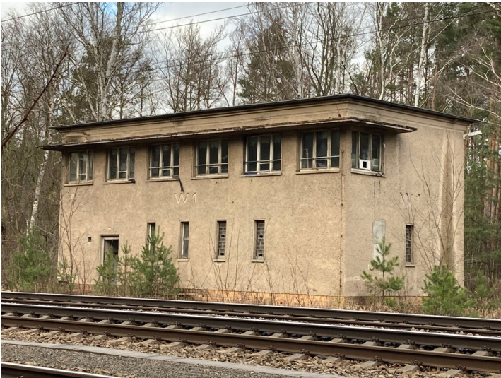
Stellwerk W1 am Ostkopf des Bahnhofs Knappenrode, Südansicht Fotograf/Urheber: Tom Pfefferkorn
