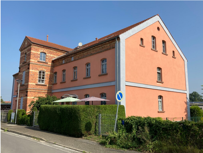
ehemaliges Arbeiterwohnhaus des Glaswerkes Strangfeld & Hannemann, Ansicht von Südosten Fotograf/Urheber: Tom Pfefferkorn
