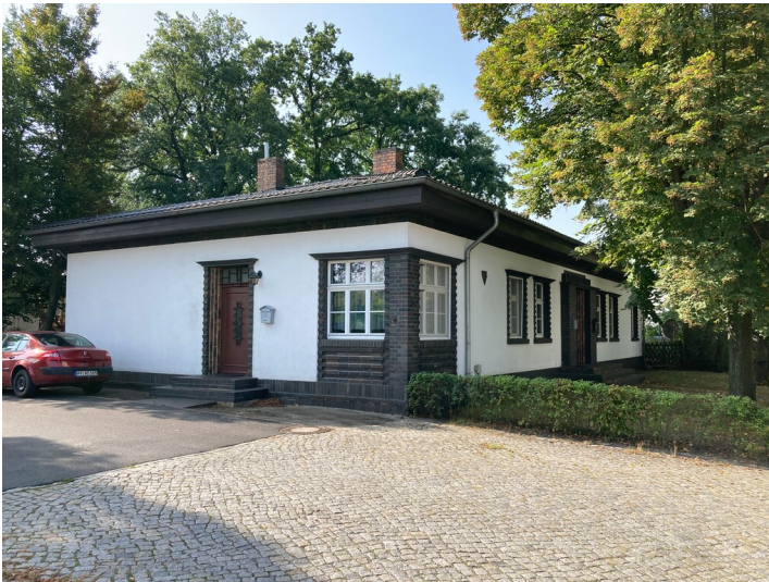
Ehemaliges Hüttenkasino Glaswerk Strangfeld & Hannemann, Ansicht von Norden Fotograf/Urheber: Tom Pfefferkorn
