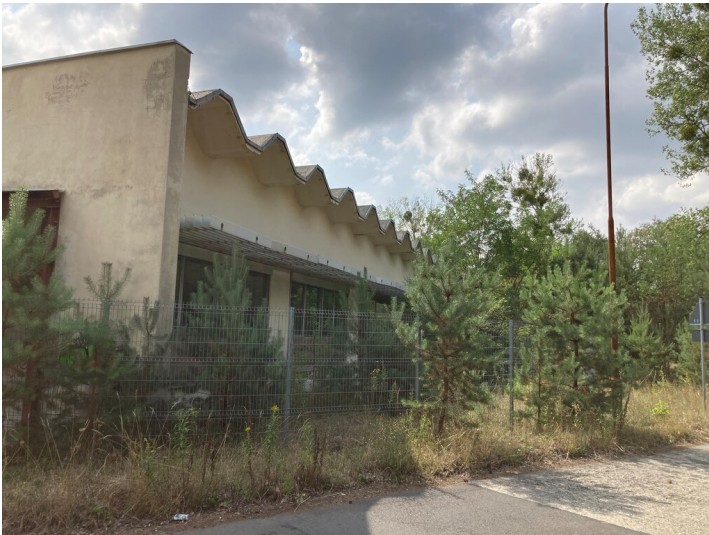
Ehemalige Großbäckerei HOBACK, Ansicht von Südwesten Fotograf/Urheber: Tom Pfefferkorn
