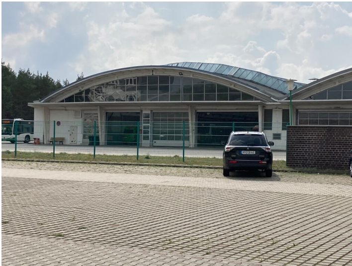
Eine Halle des Busdepots, Ansicht von Nordosten Fotograf/Urheber: Tom Pfefferkorn
