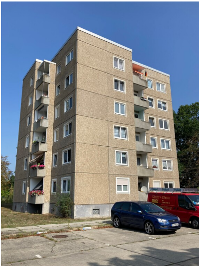
Wohnkomplex X, einziges noch verbliebenes Wohngebäude Fotograf/Urheber: Tom Pfefferkorn
