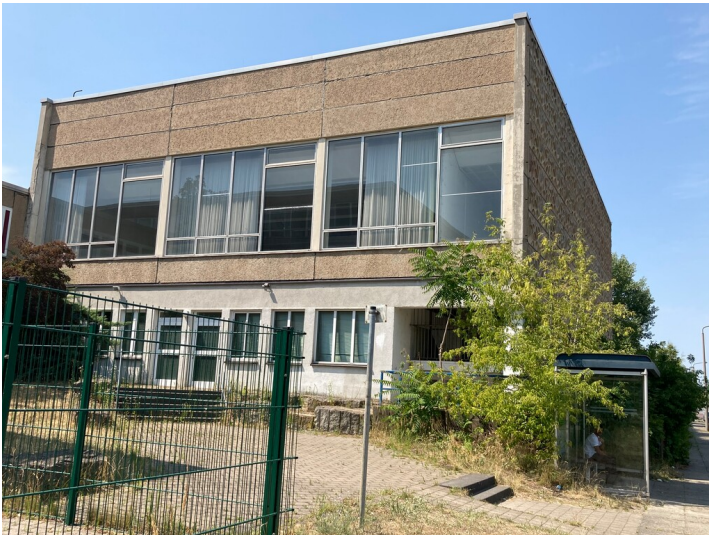
Naturwissenschaftliches Zentrum, Turnhalle, von Süden Fotograf/Urheber: Tom Pfefferkorn
