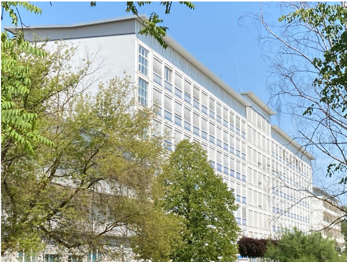
Ehemaliges Kreiskrankenhaus Hoyerswerda, Ansicht von Nordwesten Fotograf/Urheber: Tom Pfefferkorn
